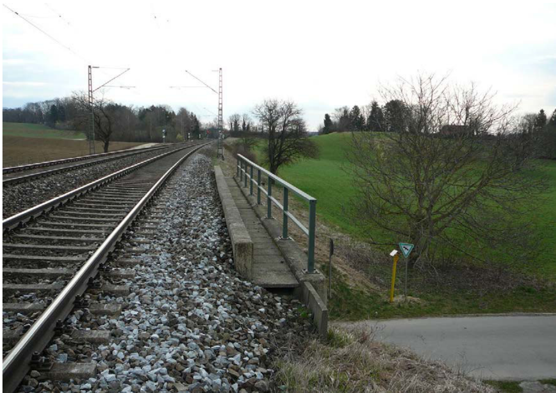
Standpunkt auf dem Brückenbauwerk, l.d.B. Blick nach Osten in Fahrtichtung München südliche Bahndammböschung als schützenswerter Bereich (Biotop 7832-0130-006 siehe Auszug FIN-Web) Ausladender Baum mit Stammdurchmesser 40 cm (jedoch keine Betroffenheit im Bau- und Endzustand)
