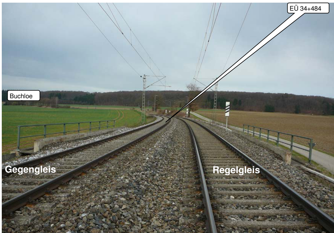
Standpunkt in Höhe Bahn-km 34+470, Blick nach Westen in Fahrtrichtung Buchloe, rechts das Regelgleis mit Fahrschienen S 54 auf Betonschwellen B 70 W links das Gegengleis mit Fahrschienen S 54 auf Betonschwellen B 70 W Oberleitung an Einzelmasten, Nachspannfelder zu beiden Köpfen der westl. OL-Maste
