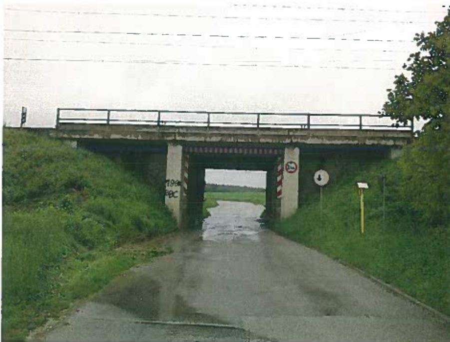
Bild 1: EÜ km 34,484 bei Kottgeisering
